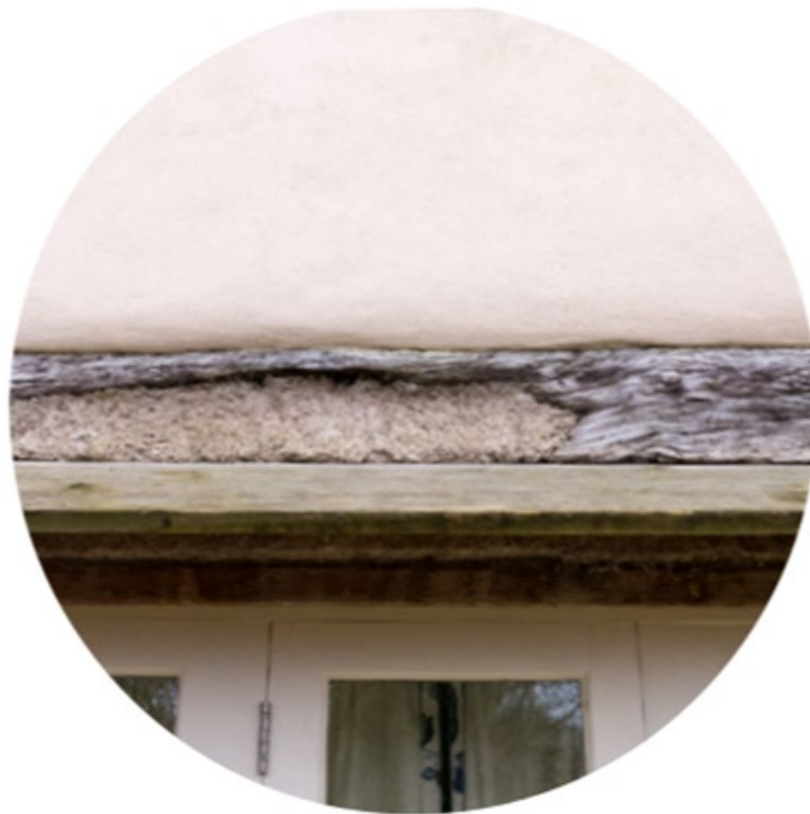
Lahonneita hirsirakenteita on mahdollista korjata hamppu-kalkkimassan avulla.
