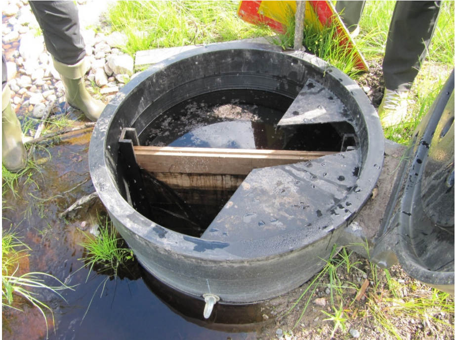
Kosteikon yhteyteen asennettu munkkipato.
