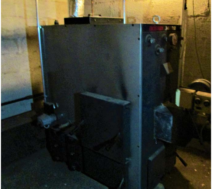
Lämpökeskuksen hakekattila.
