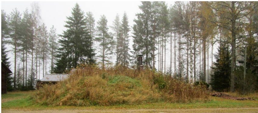
Lämpökeskus asuinrakennukselta päin katsottuna.
