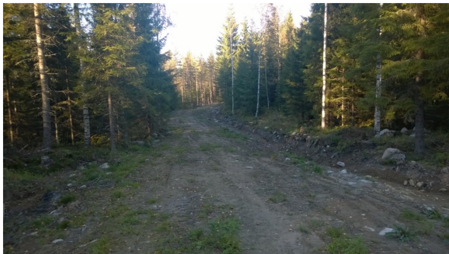
Rakenteilla oleva kahden maanomistajan yhteinen tie. Tiepohja on valmis.
