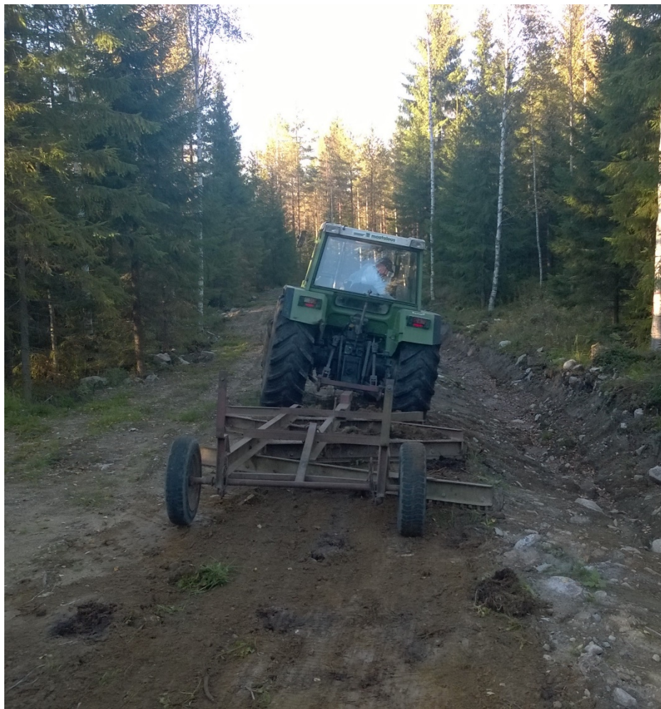
Lanaus tehtiin tiepohjan kuivuttua kevyellä kalustolla.
