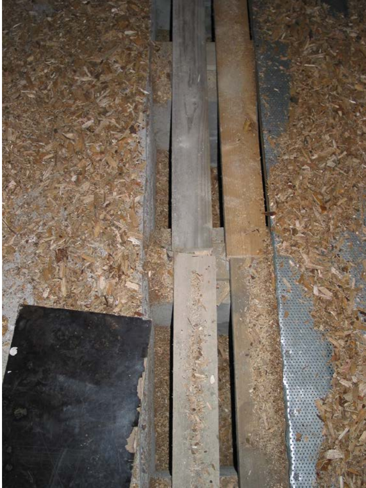
Lämpökeskuksen hakevaraston ilmananava ja reikälevypohja.
