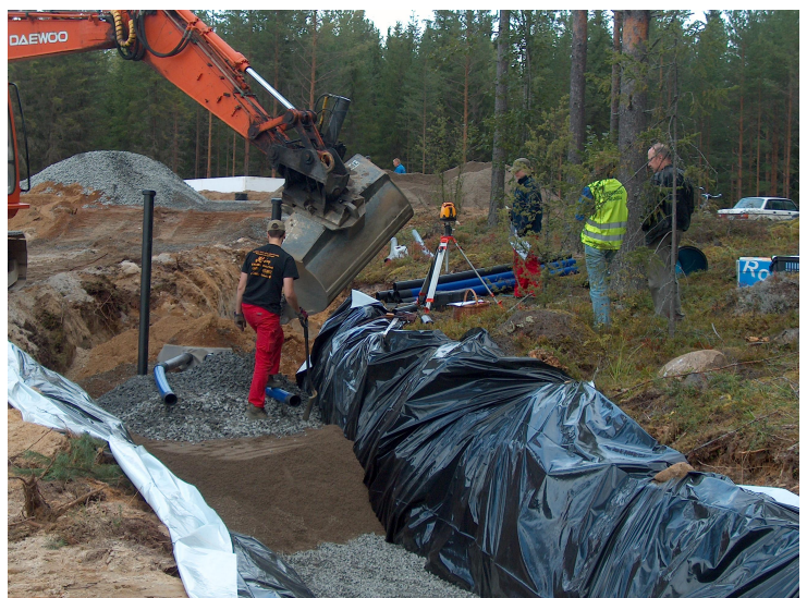
Kuva 3. Maasuodattamon rakentaminen (kuva: Heli Tammelin).
