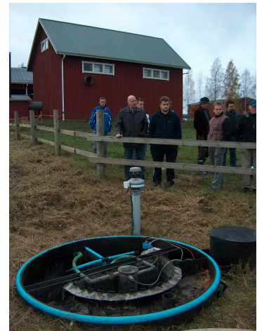
Kuva 2. Maitotilan panospuhdistamo (kuva: Heli Tammelin).
